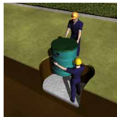
3a. POSIZIONAMENTO DELLA VASCA
