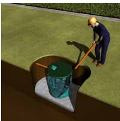
4a. COLLEGAMENTO DELLE TUBAZIONI
