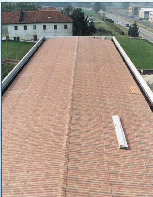
Con l'applicazione del sottocoppo Nuance la copertura del tetto mantiene sin dal principio un aspetto antichizzato anche senza i coppi. Infatti questo effetto ottenuto nell'ultimo strato di impasto mediante un mix di ben tre colorazioni, garantisce nell'ambiente circostante il rispetto architettonico ed il rispetto dei vincoli paesaggistici.
