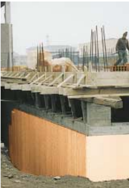
Particolare dell'isolamento del sottofinestra
